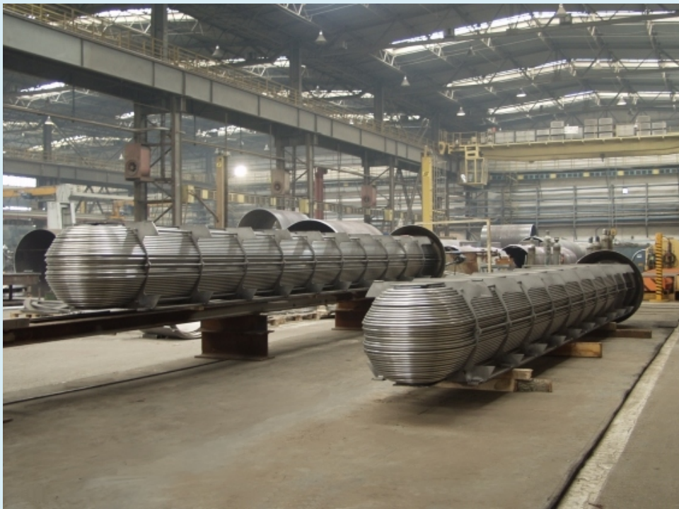
Hala montażowa wymienników ciepła Heat exchangers assembly room
