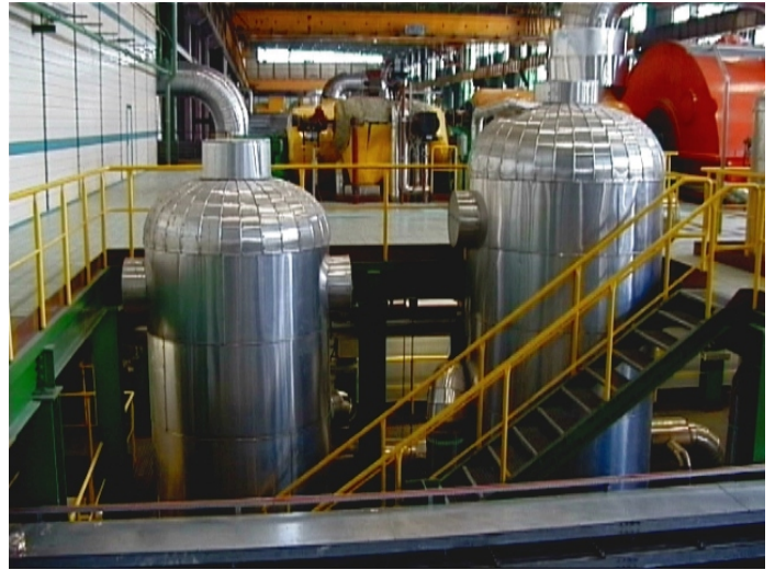
Podgrzewacze regeneracyjne zamontowane w bloku energetycznym Regenerative preheaters installed in power unit
