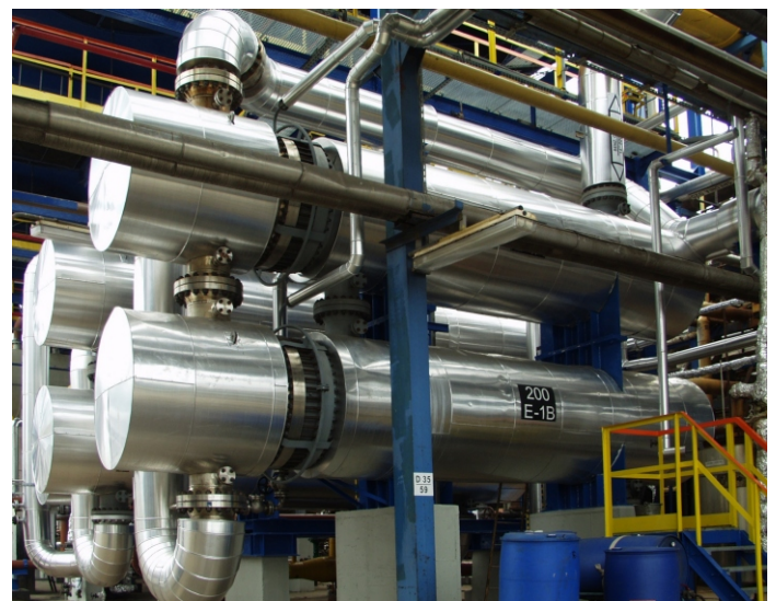
Wymienniki płaszczowo-rurowe w rafinerii ropy naftowej Shell and tube heat exchangers in refinery
