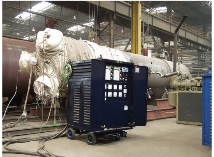
Obróbka cieplna po spawaniu podgrzewaczy typu HP Heat treatment of HP type preheaters after welding
