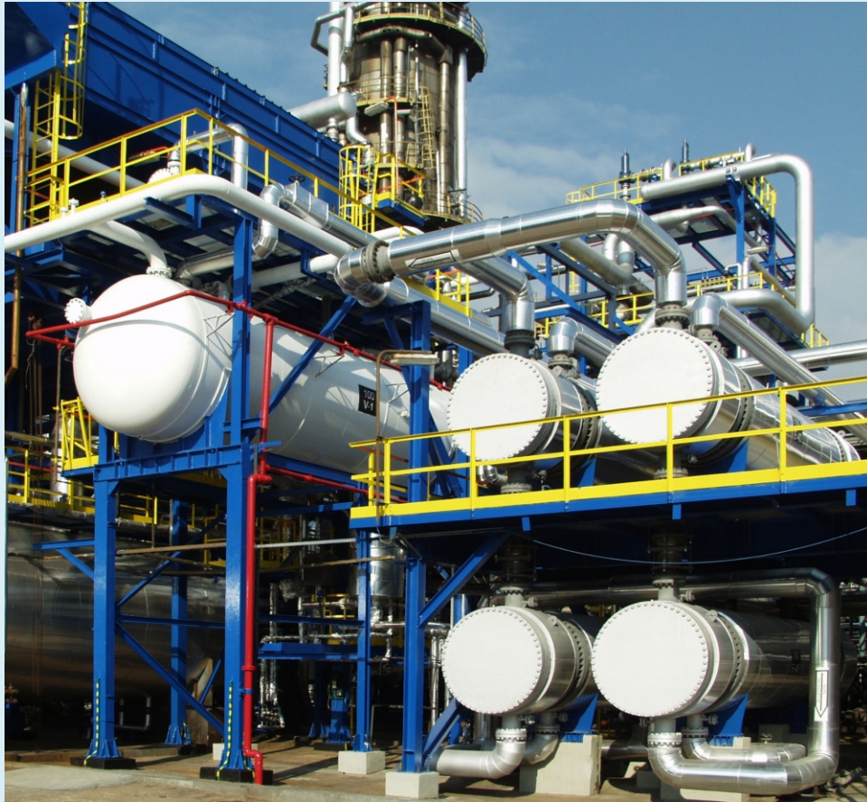
Wymienniki płaszczowo-rurowe w rafinerii ropy naftowej Shell and tube heat exchangers in refinery
