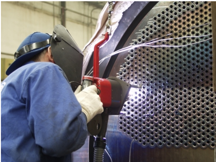
Spawanie końców rurek do ściany sitowej Tube tips welding to tubesheet
