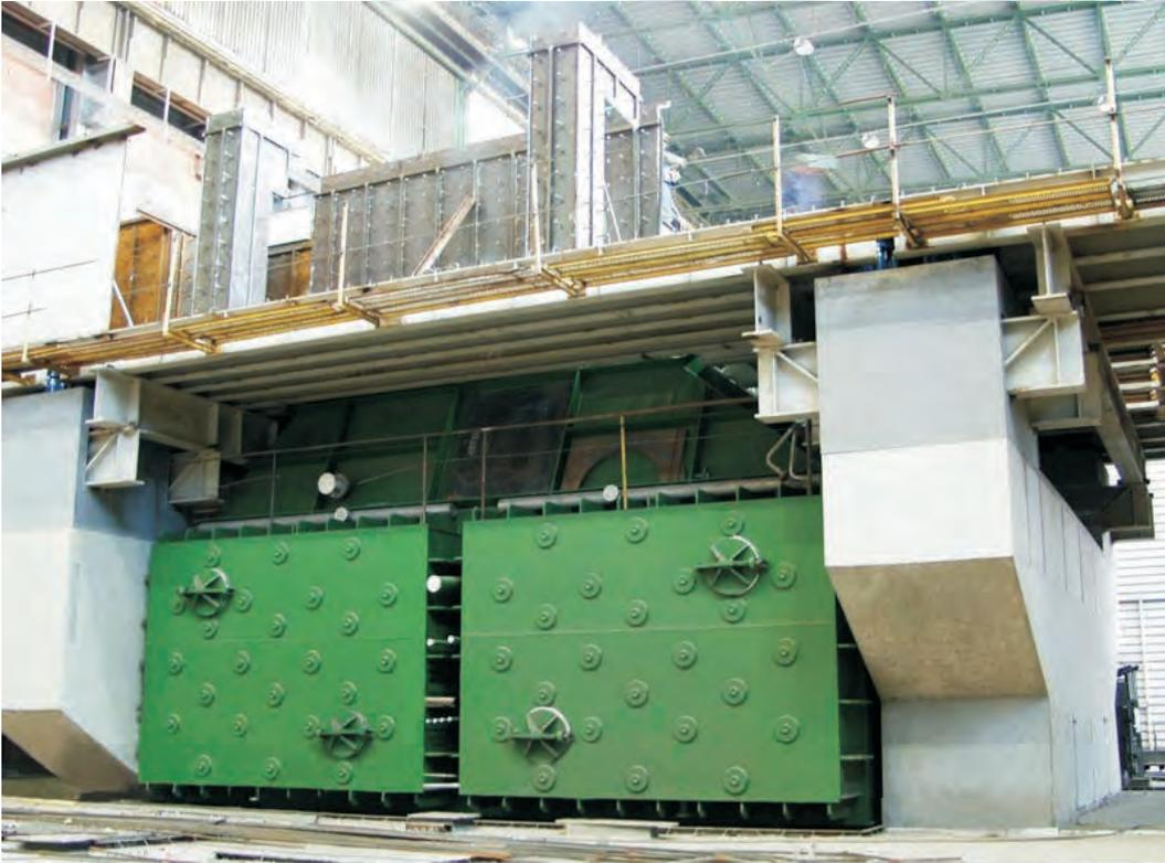
*Dampfkondensator in einem Energetikblock*
