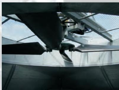
*Ventilatoren für Erdgasluftkühler*
