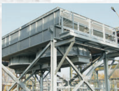
Montaż próbny chłodnicy powietrznej
