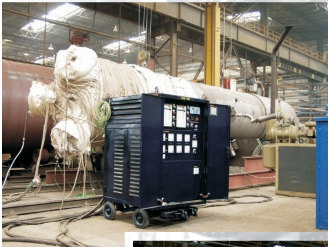
Obróbka cieplna po spawaniu wysokoprężnych podgrzewaczy regeneracyjnych
