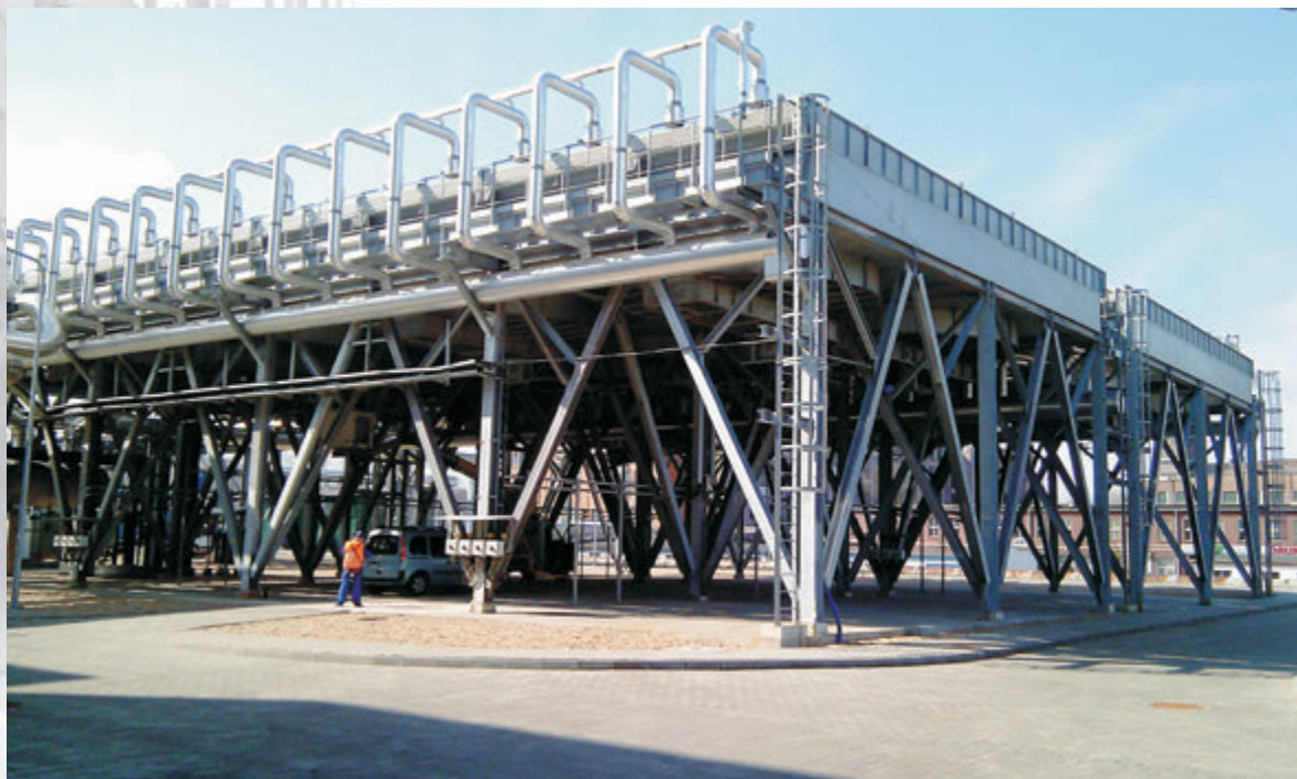
Chłodnica powietrzna glikolu w elektrociepłowni
