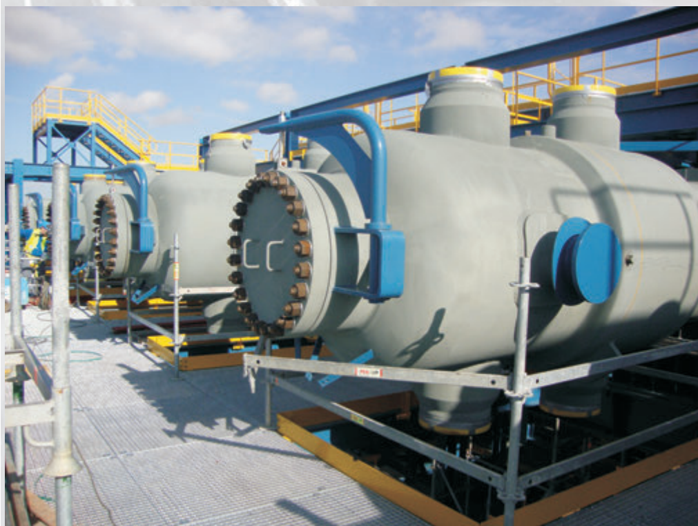
Bateria wymienników ciepła zainstalowana w elektrowni słonecznej
