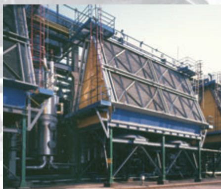
Chłodnica powietrzna z wiązkami rurowymi usytuowanymi w układzie dachowym
