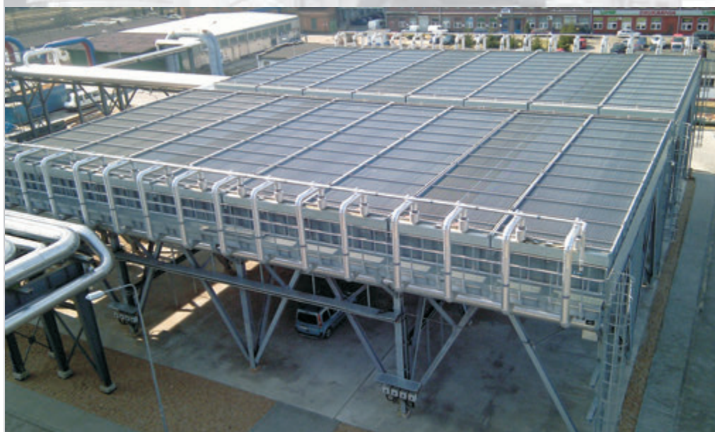
Chłodnica powietrzna glikolu w elektrociepłowni
