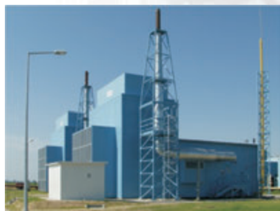
Chłodnice powietrzne gazu ziemnego obudowane dźwiękoszczelną osłoną
