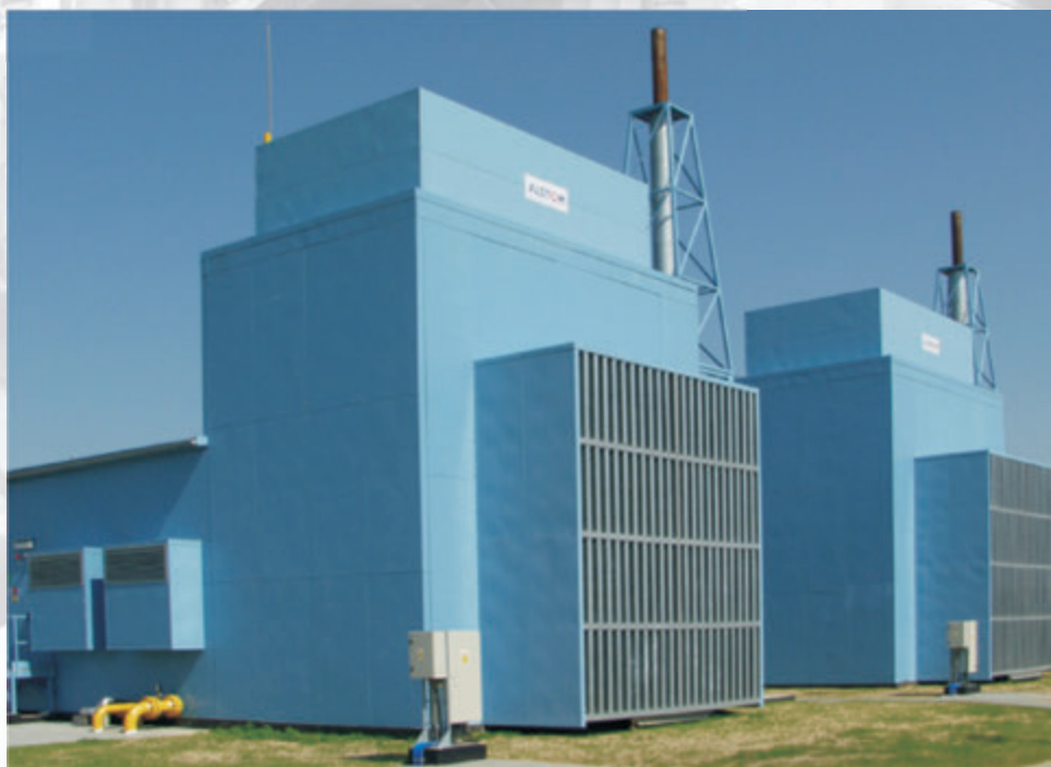
Chłodnice powietrzne gazu ziemnego obudowane dźwiękoszczelną osłoną
