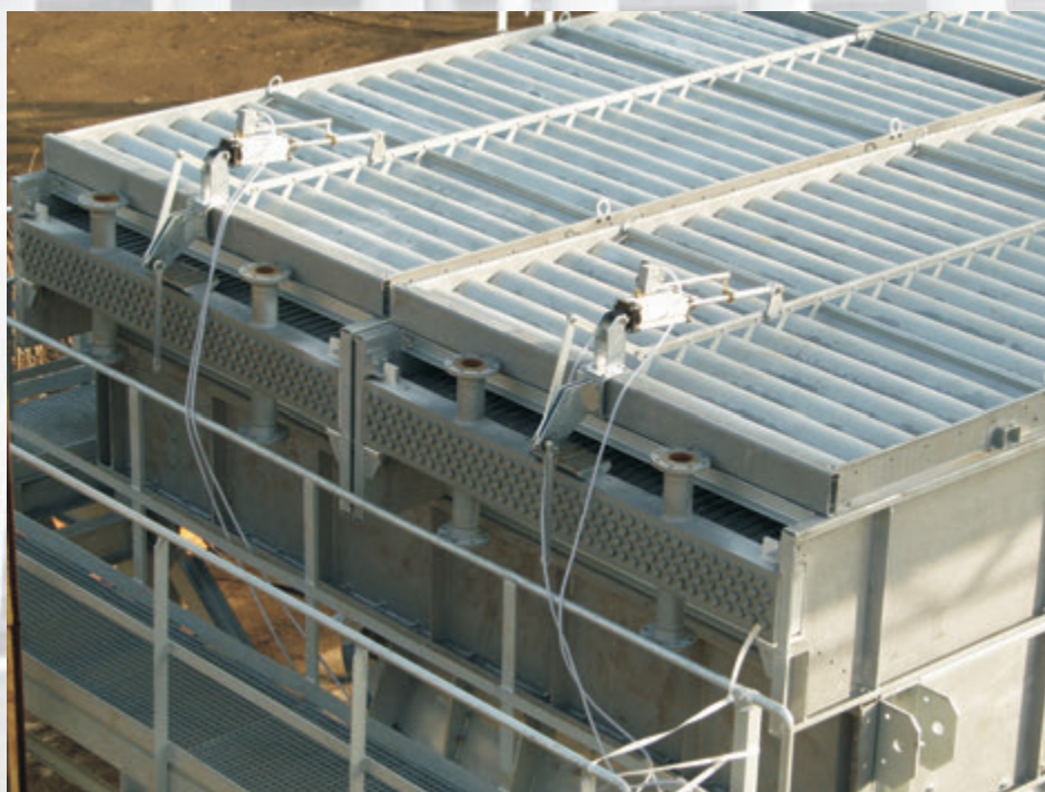
Żaluzje sterowane automatycznie w chłodnicy powietrznej
