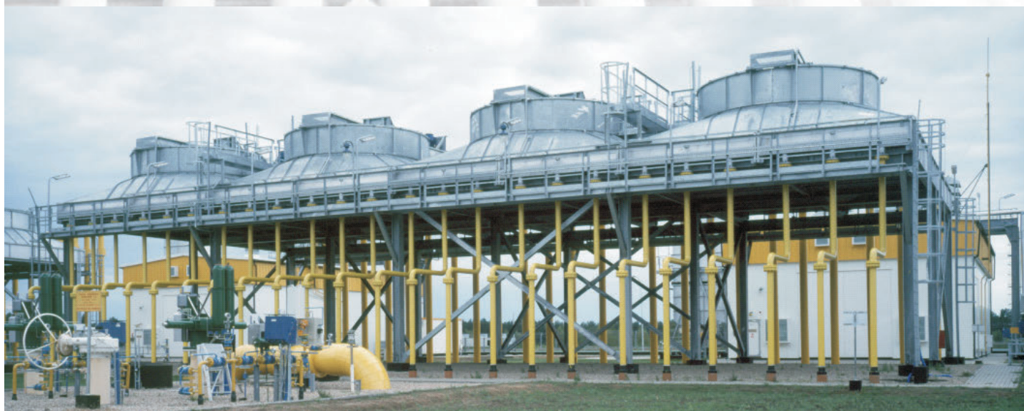
Żaluzje sterowane automatycznie w chłodnicy powietrznej
