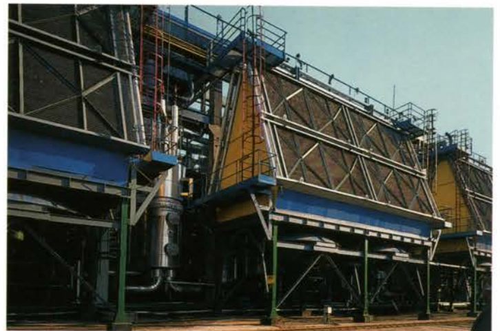
Аппарат воздушного охлаждения с пучками труб в крышном расположении. Air cooler with tube bundles in roof arrangement.
