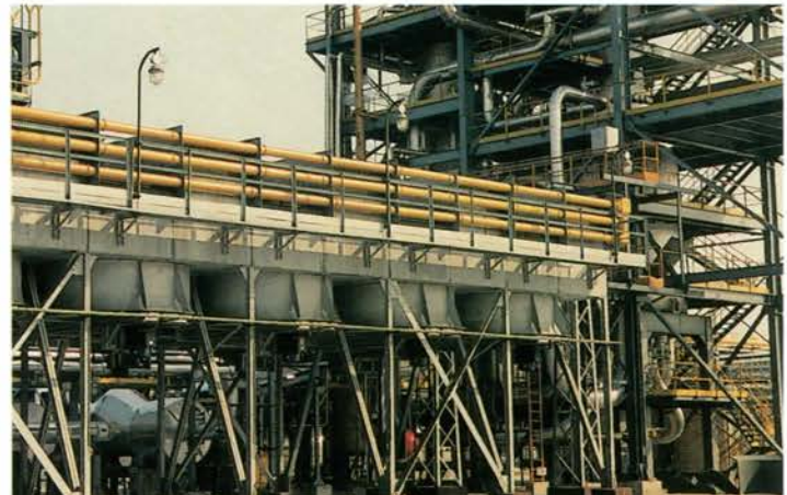
Холодильник синтез газа с трубными камерами (p = 320 бар). Synthesis gas air cooler with manifold type headers (p = 320 bar).
