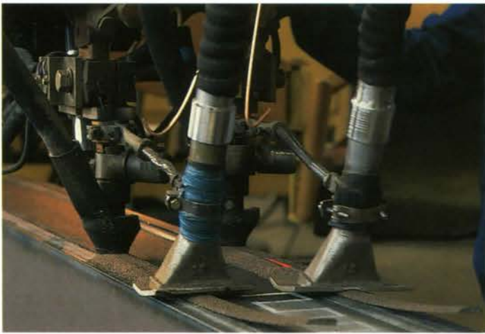
Сварка прямоугольных камер при помощи устройства с 2-мя головками. Double-head welding of rectangular headers.
